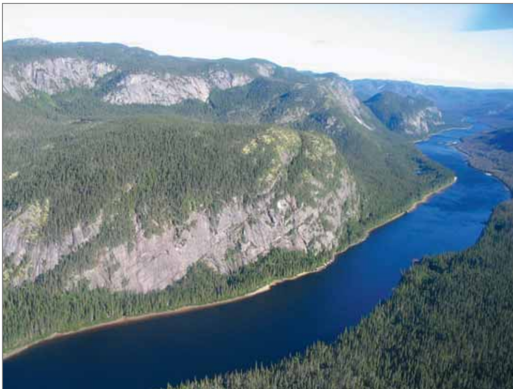
Photo 19-10 : Escarpement rocheux qui bordera le réservoir de la Romaine 3 (PK 164 de la Romaine)
