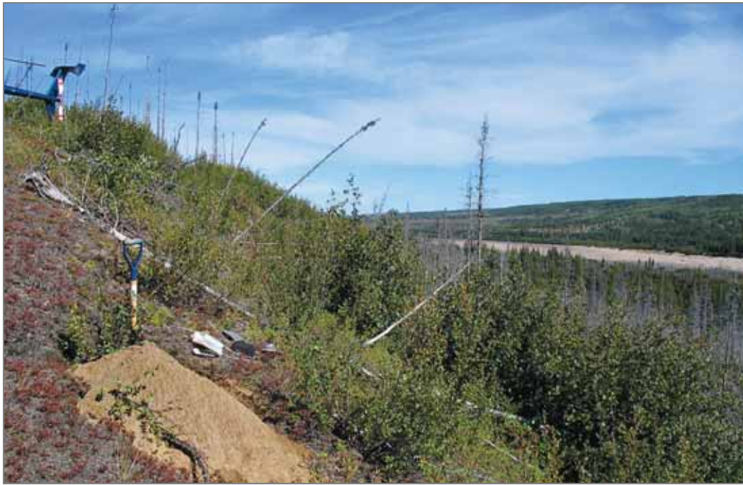
Photo 19-6 : Talus de terrasse sableuse fortement sensible à l'érosion qui sera rejoint par le réservoir de la Romaine 4 (PK 252 de la Romaine)
